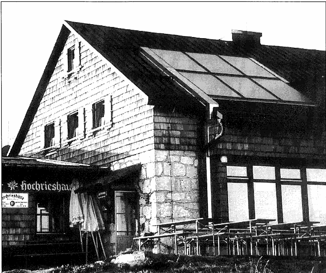
Mit der Erneuerung der Heizung wurde auch eine Solaranlage installiert.
