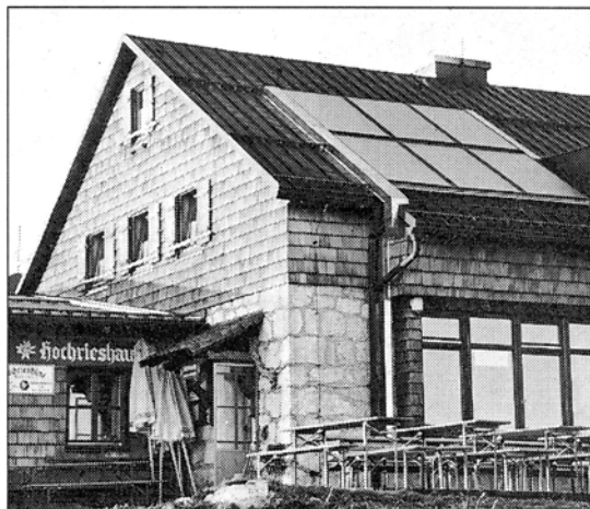
Vielen Besuchern sind sie vielleicht noch gar nicht aufgefallen — die energiesparenden Solarkollektoren auf dem Dach des Hochries-Gipfelhauses. Foto: Franz Knarr
